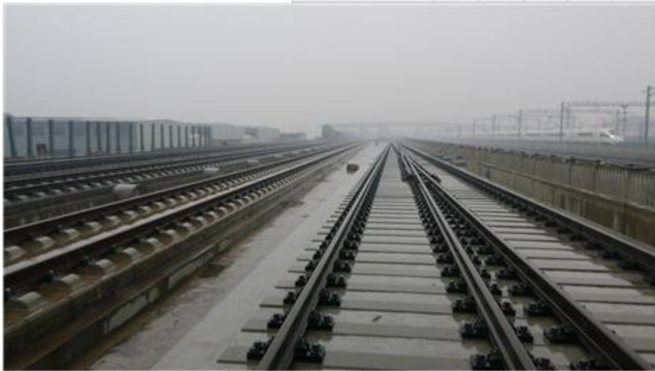
图一：沪昆高铁杭长线施工前铁路桥基面
