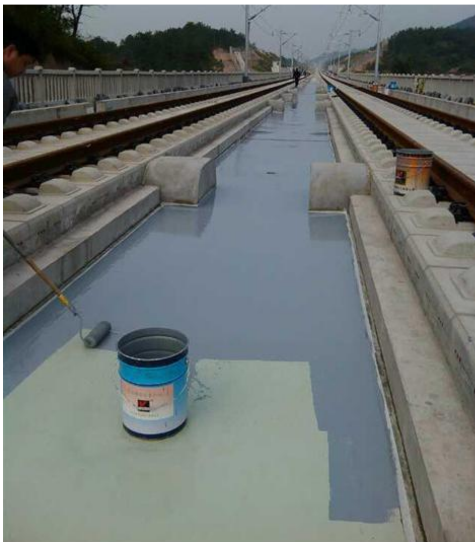
图六：沪昆高铁杭长线高铁防水涂料面漆施工中
