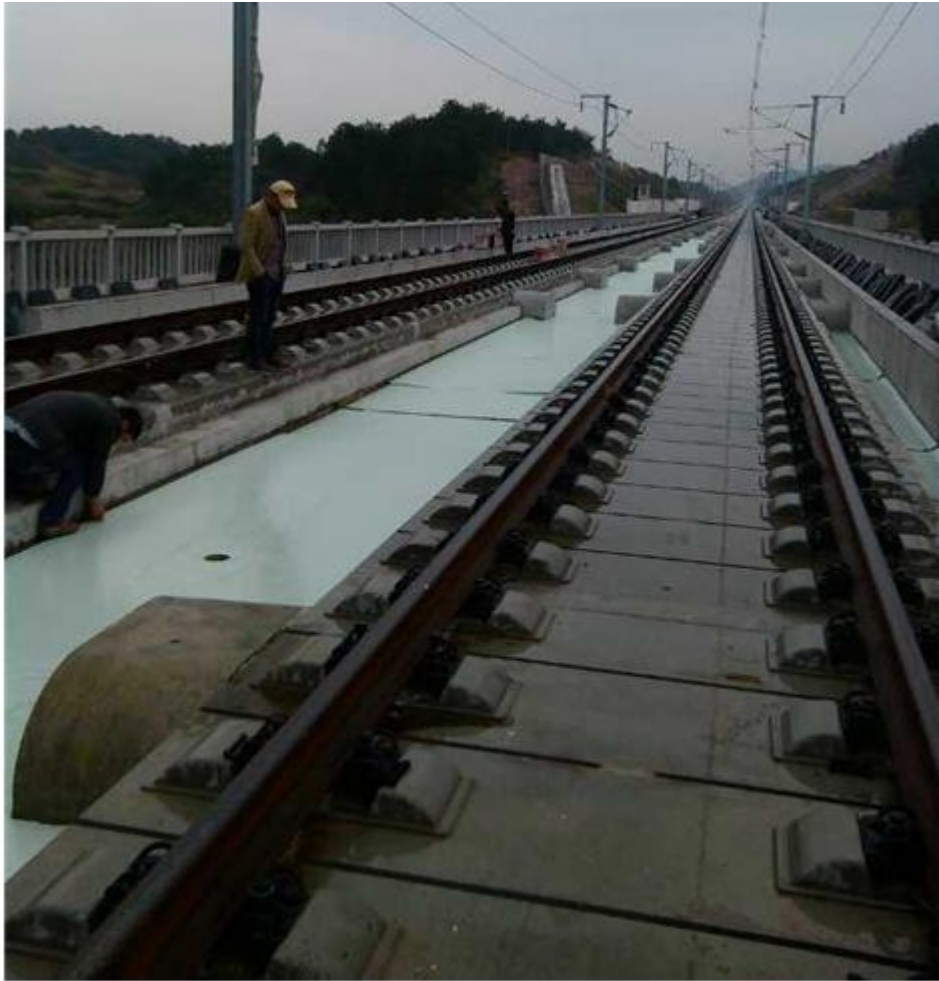
图五：沪昆高铁杭长线高铁防水涂料中间漆施工中
