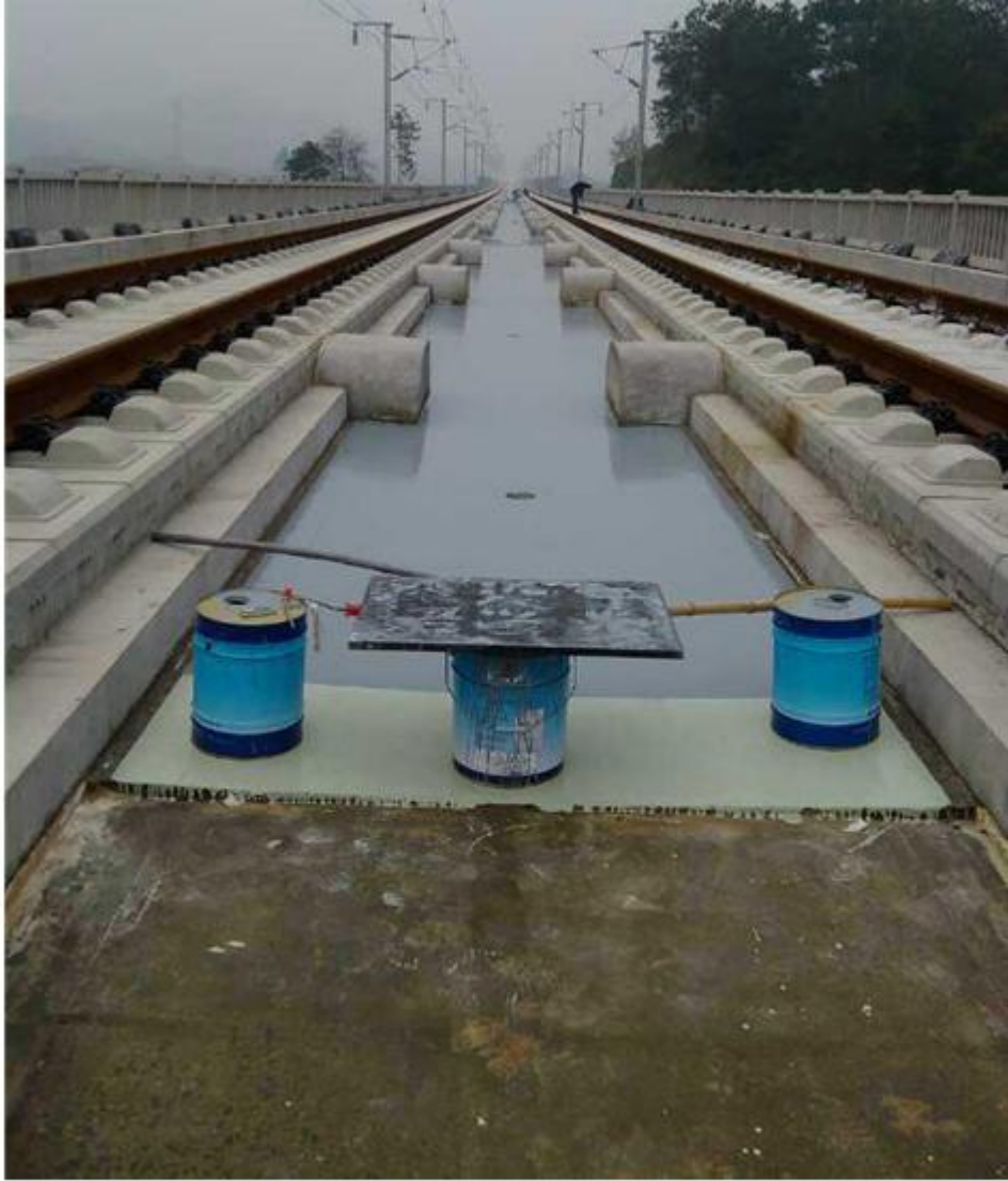
图七：沪昆高铁杭长线高铁防水涂料施工完毕当日现场
